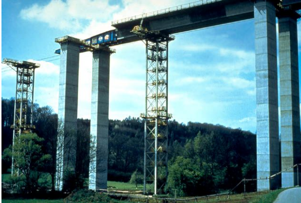
nh 1. 1. Thi công đúc đẩy có dùng trụ tạm
